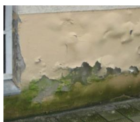
⊘ иные разрушения красочного слоя
