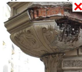
⊘ обнажение крепежных элементов
