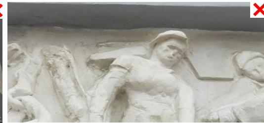
⊘ потеря пластики декора из-за многослойных окрашиваний и (или) окрашиваний без восполнения дефектов элементов декора
