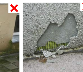
⊘ иные разрушения красочного слоя
